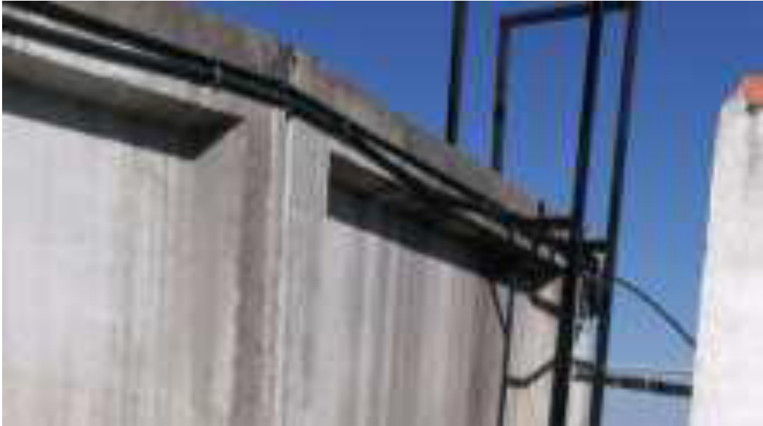
ESCALERA DE PATES LATERAL. -SECTOR CERRONES-
