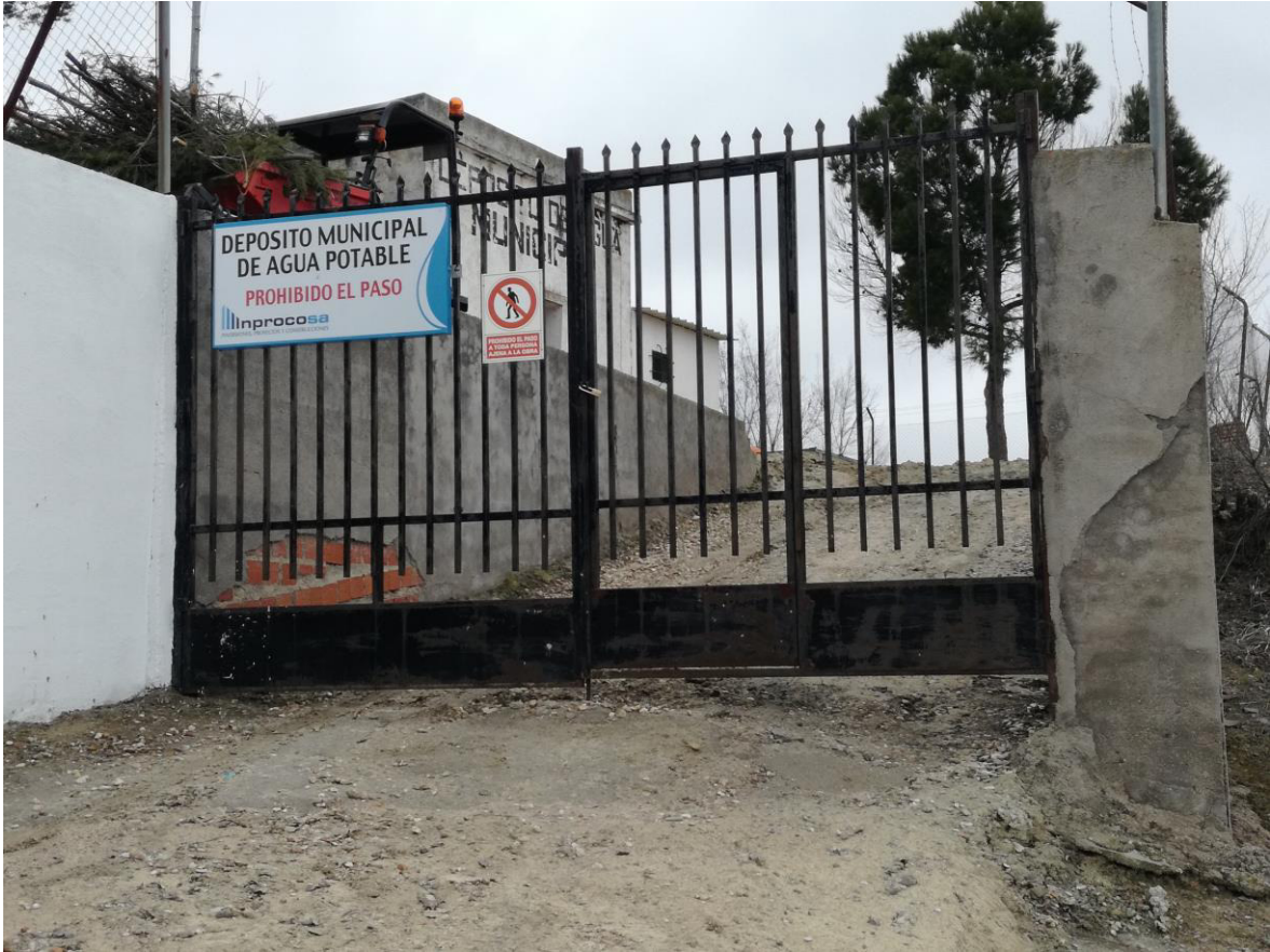
DEPÓSITO DE AGUA POTABLE -SECTOR CERRONES- ACCESO PRINCIPAL, por TO-2437
