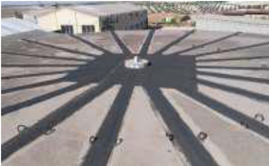
CUBIERTA DE DEPÓSITO DE AGUA POTABLE. -SECTOR CERRONES-
