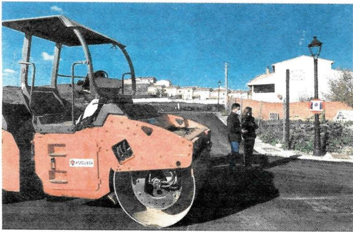
reas a realizar consistían en actuaciones previas sobre las tapas de alcantarillado e imbornales, fresado de pavimento existente para la posterior imprimación y pavimentación de las calles. El plan de asfaltado se ha desarrollado en una superficie superior a los
